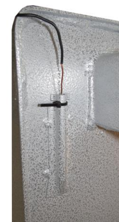
Рис.4. Пример установки баллона терморегулятора в гильзе котлов КАРАКАН
